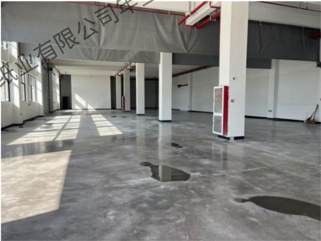
图 2-3 项目所在地空置厂房照片
